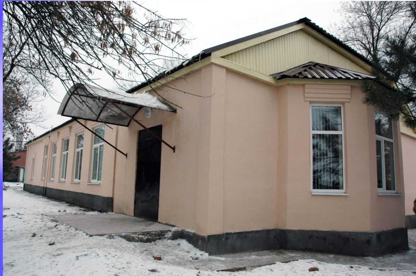
Здание поликлиники участковой больницы п. Реконструктор после капитального ремонта
